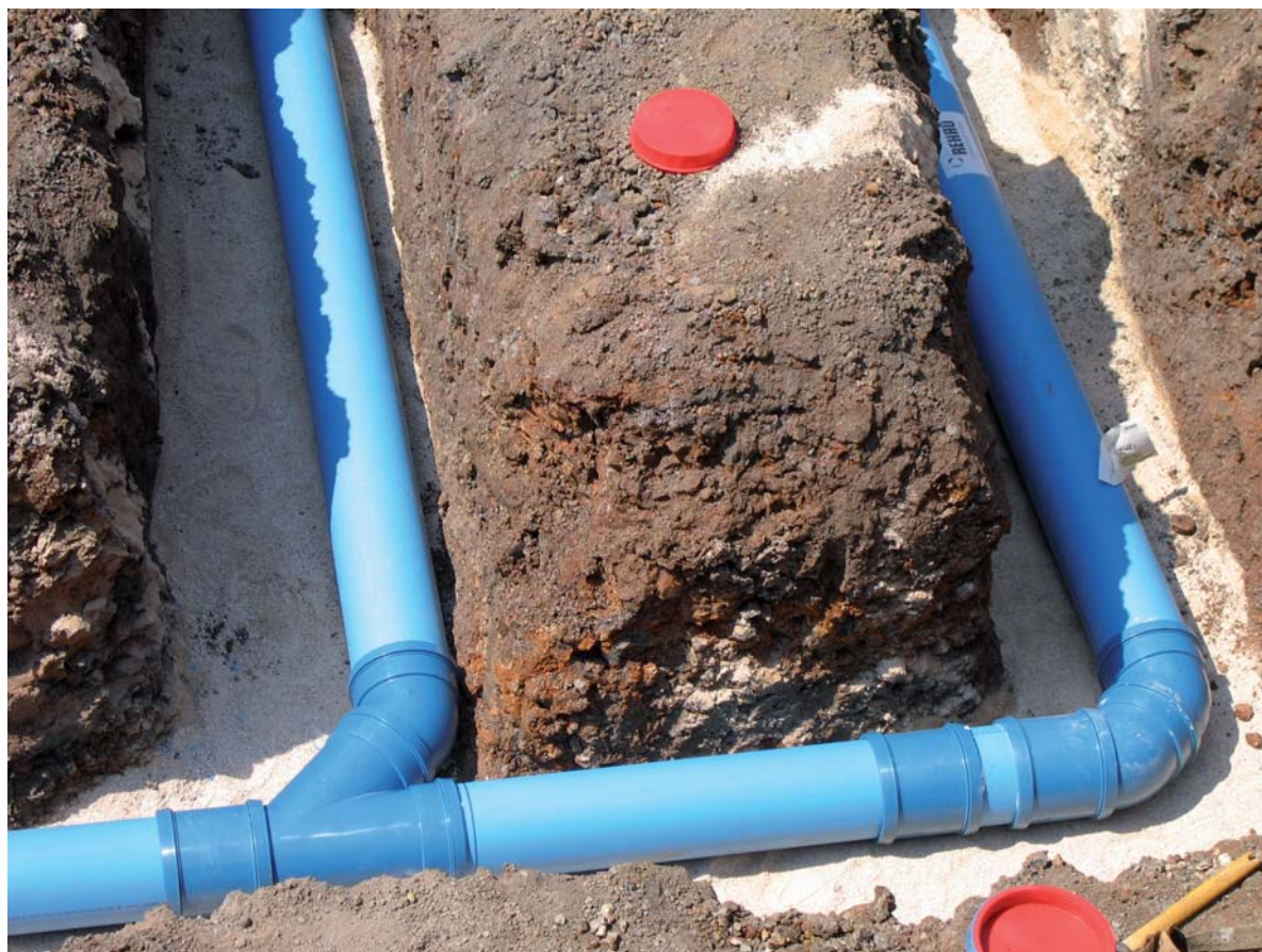
Zanjas de poca profundidad
