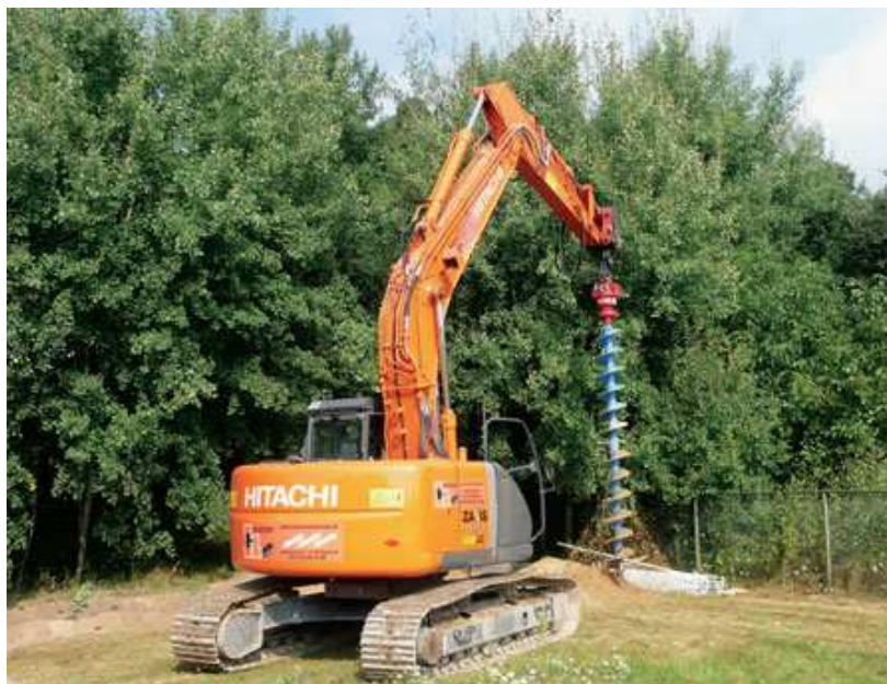
Fig. 10 Equipo de sondeo para la instalación de sondas geotérmicas verticales helicoidales
