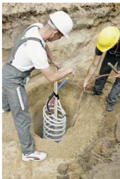
Fig. 11 Instalación rápida y sencilla de una helicoidal de PE-Xa
