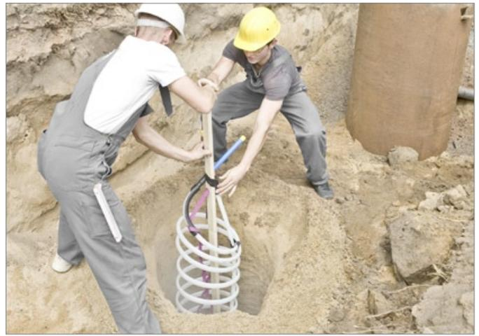
Abbildung 10: Einbringen der RAUGEO Helix PE-Xa
