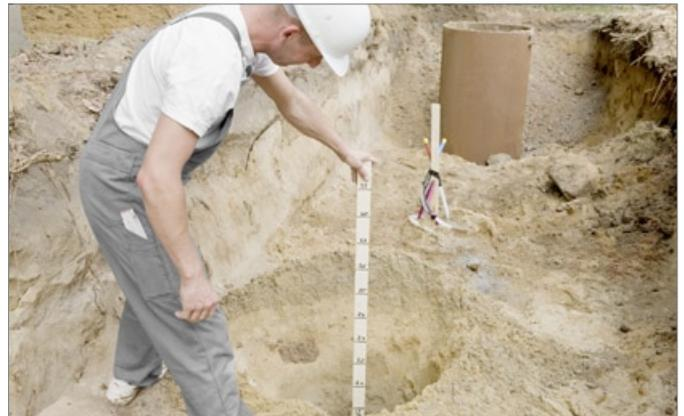
Abbildung 7: Tiefenmessung, im Hintergrund Stützrohr
