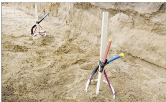
Abbildung 12: Installierte RAUGEO Helix PE-Xa
