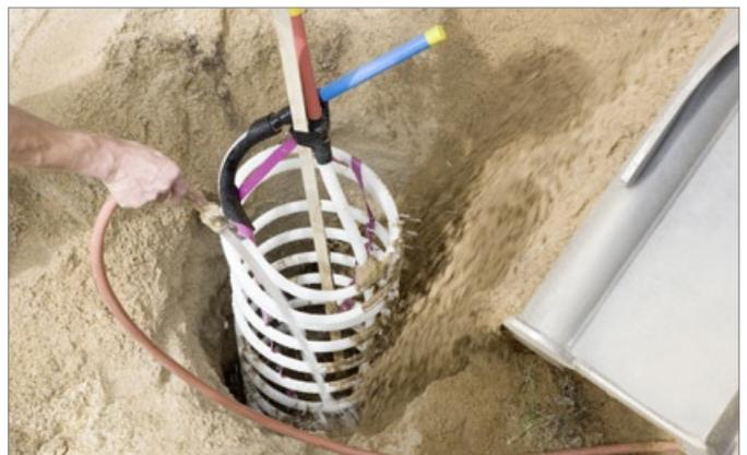
Abbildung 11: Verfüllung der RAUGEO Helix PE-Xa
